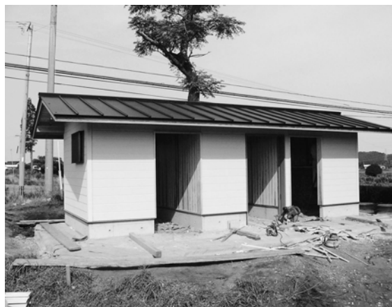
▲建設中の野方公民分館運動場公衆便所
