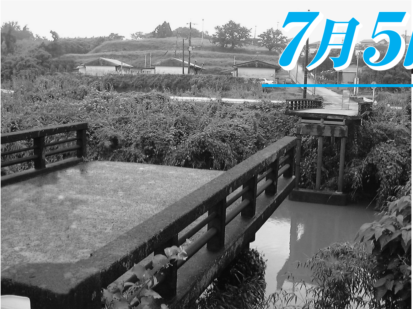
橋桁の流出した天子橋
