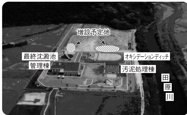
大崎クリーンセンター
