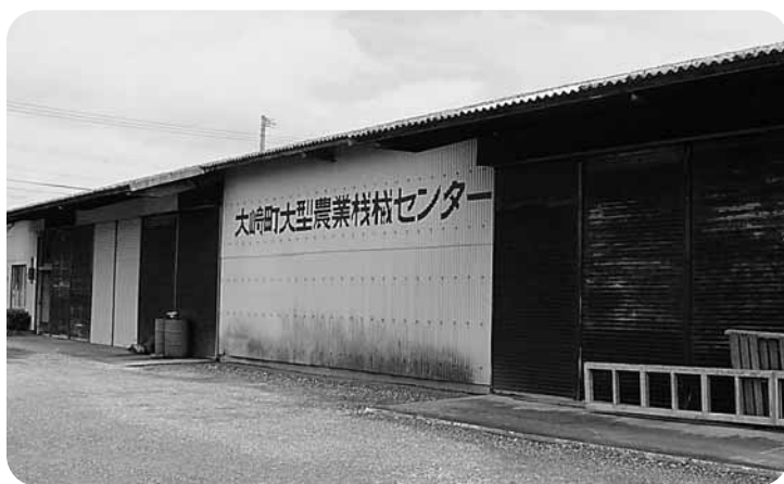
老朽化の著しい農業機械センター
