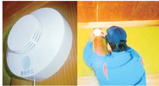
住宅用火災警報器と消防団による設置作業
