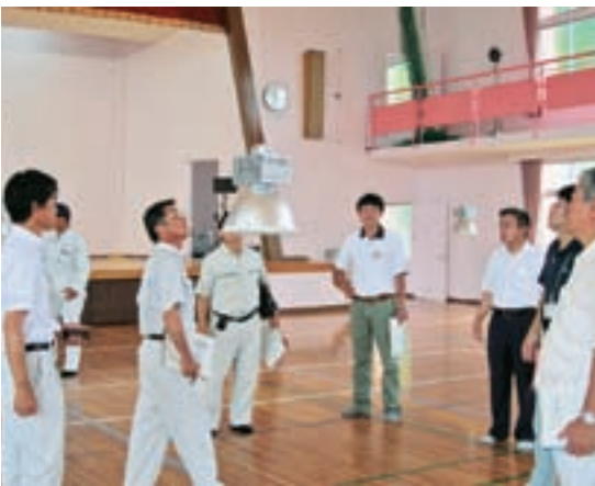
大崎小学校屋内運動場照明器具設置工事
