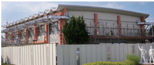
現在進行中の屋内運動場耐震化工事(野方小)
