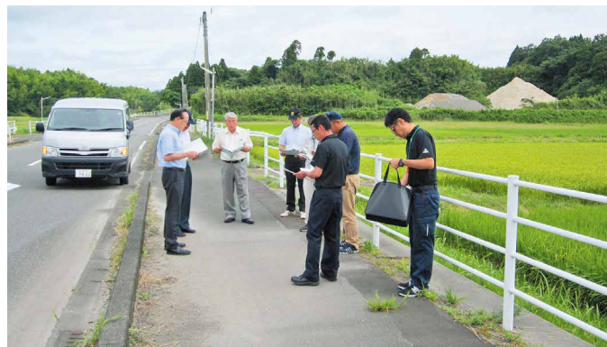
避難誘導灯設置工事を調査
