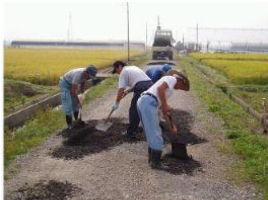
共同作業による砂利の敷き均し
