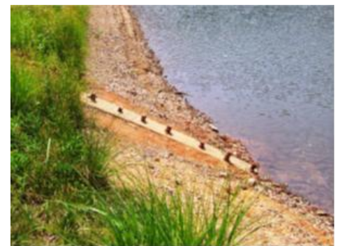
斜樋と取水栓
