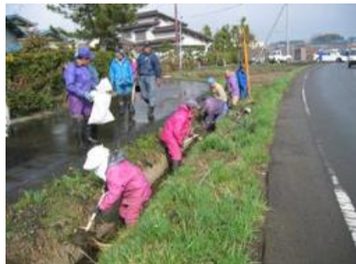
側溝の泥上げ
