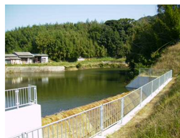
金網フェンスの設置状況
