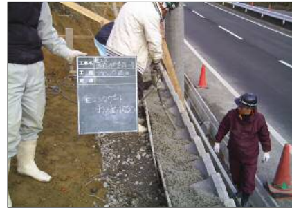
ブロック積みの施工
