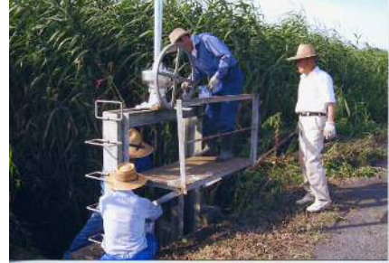
ゲートの点検
