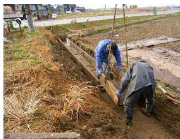
水路の再布設
