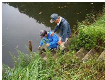
取水施設の点検
