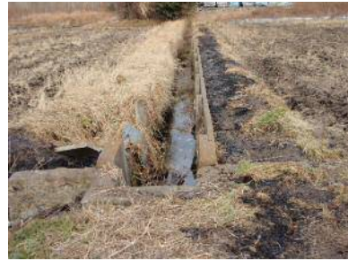
老朽化した水路（全景）
