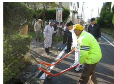
水路蓋の設置 (専用器具使用)
