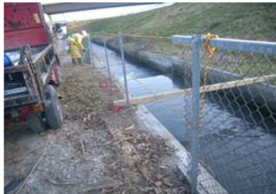
金網フェンスの 設置
