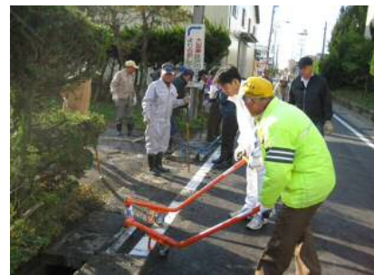
水路蓋の設置 (専用器具使用)
