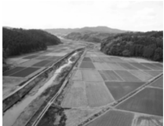
▲大崎中央大橋から望む持留川兩岸の計画地区
