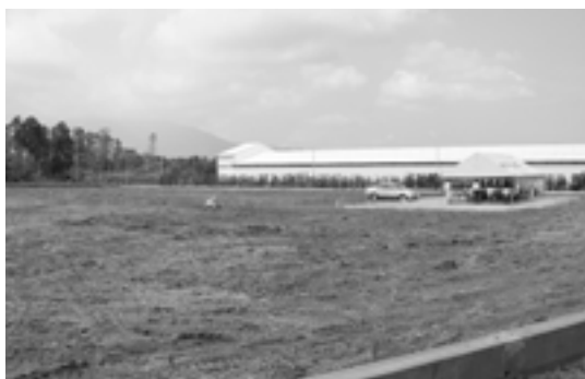
▲野方地内の建設地
