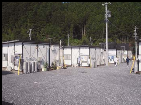
仮設住宅が建ち始め、着々と入居が進んでいました。 8 / 6 撮影 社会教育課 仮水公司
