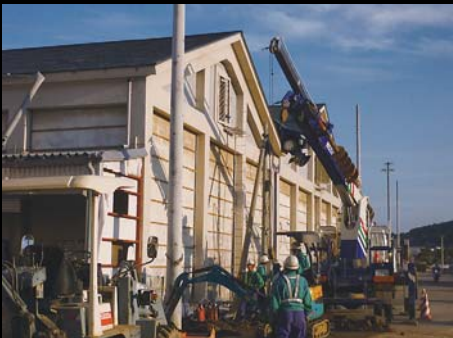
工場の屋根に打ち上げられた車を引き下ろしています。 7 / 28 撮影 総務課 今吉孝志
