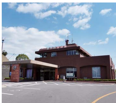
▲昭和52年に建てられた本庁舎
