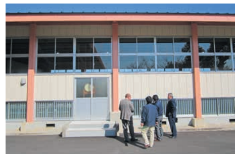
▲大崎中学校武道場耐震補強等工事
