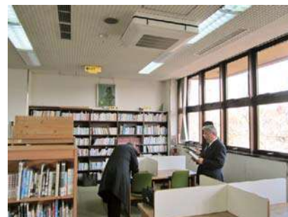
▲大崎町立図書館空調設備改修工事
