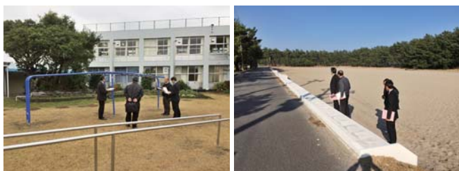
▲監査の様子 左：大丸小学校遊具新設工事 右：ビーチスポーツ専用競技場整備工事
