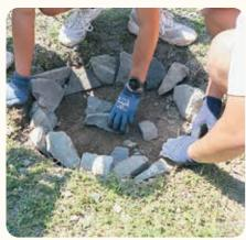
▲ 道具を使用して穴を掘り地 盤を固める石で補強します
