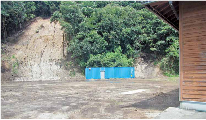
林地崩壊現場
