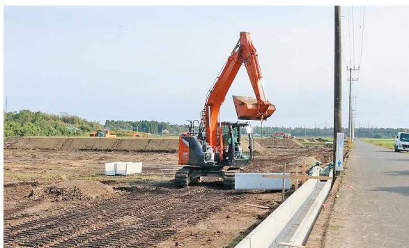
整備が進められるほ場（益丸地区）
