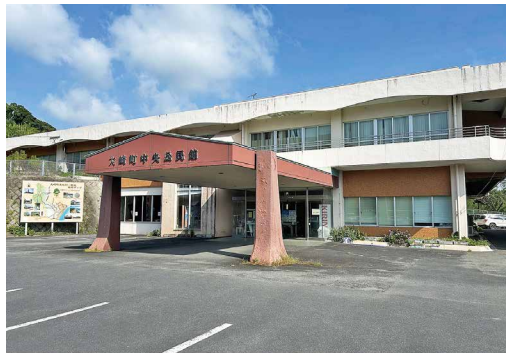
中央公民館（昭和49年3月30日建設）
