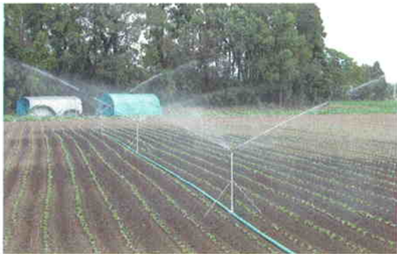
●畑地かんがい事業により設置されたスプリンクラーの稼動状況
