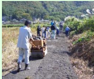
未舗装農道の舗装
