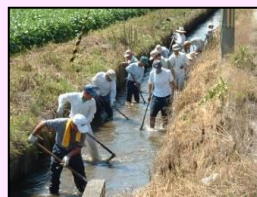
水路の泥上げ
