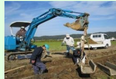
コンクリート水路の更新
