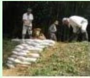
漏水箇所の補修
