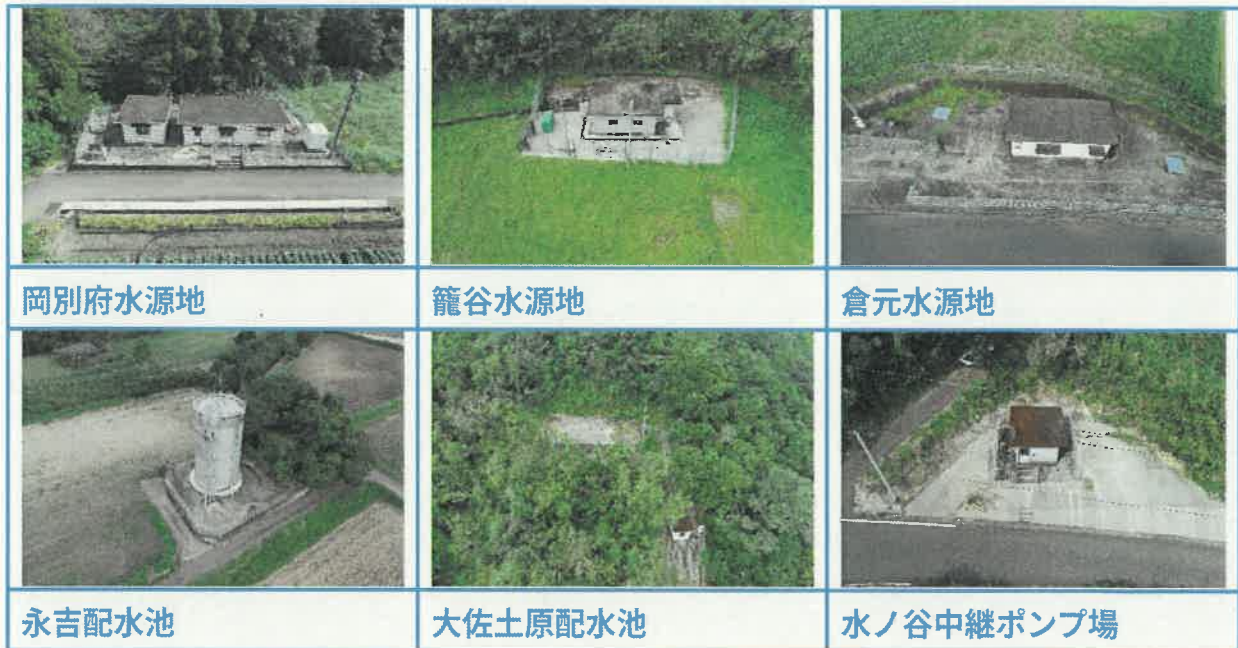
【図12】上水道施設（一部）
