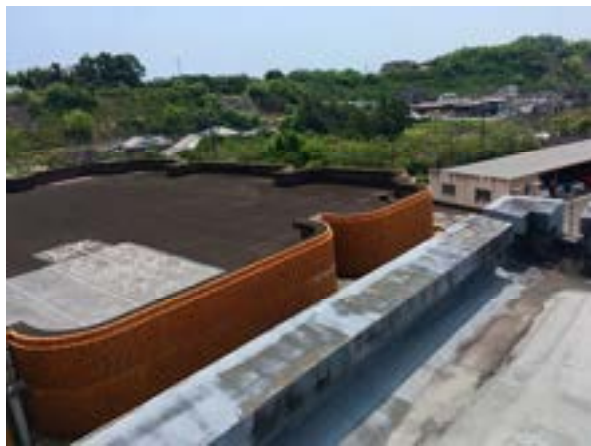
屋上劣化 補修後
